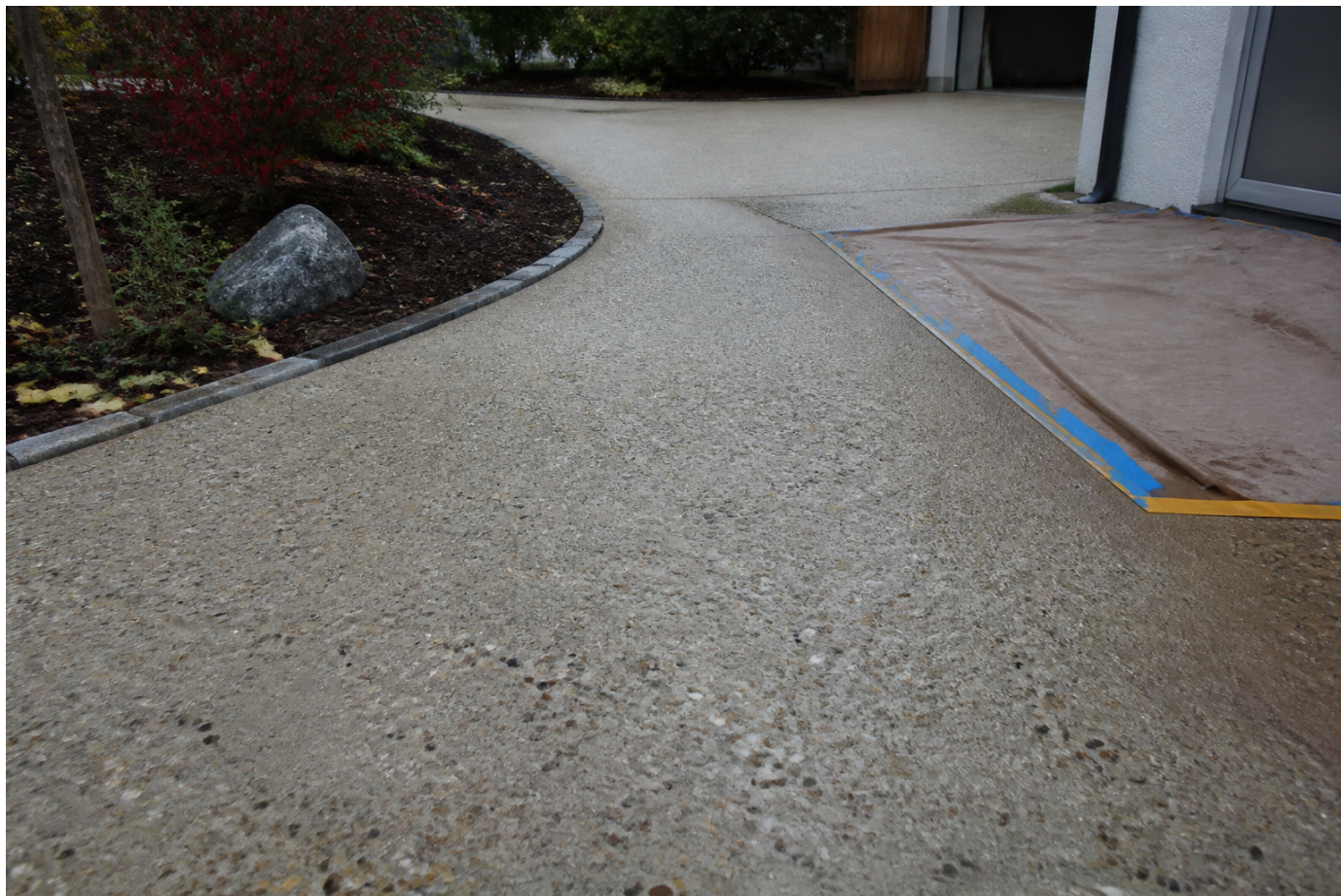
PHOTO DE RÉFÉRENCE Aspect recherché après lavage : une surface continue avec granulats apparents.
