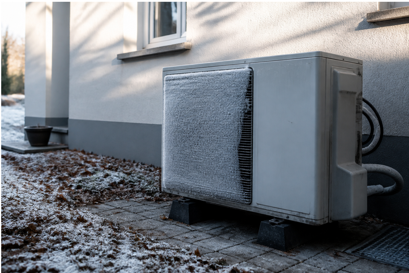
PHOTO Un givrage ponctuel peut accompagner un cycle de dégivrage ; une glace persistante ou un ventilateur bloqué doit être signalé.
