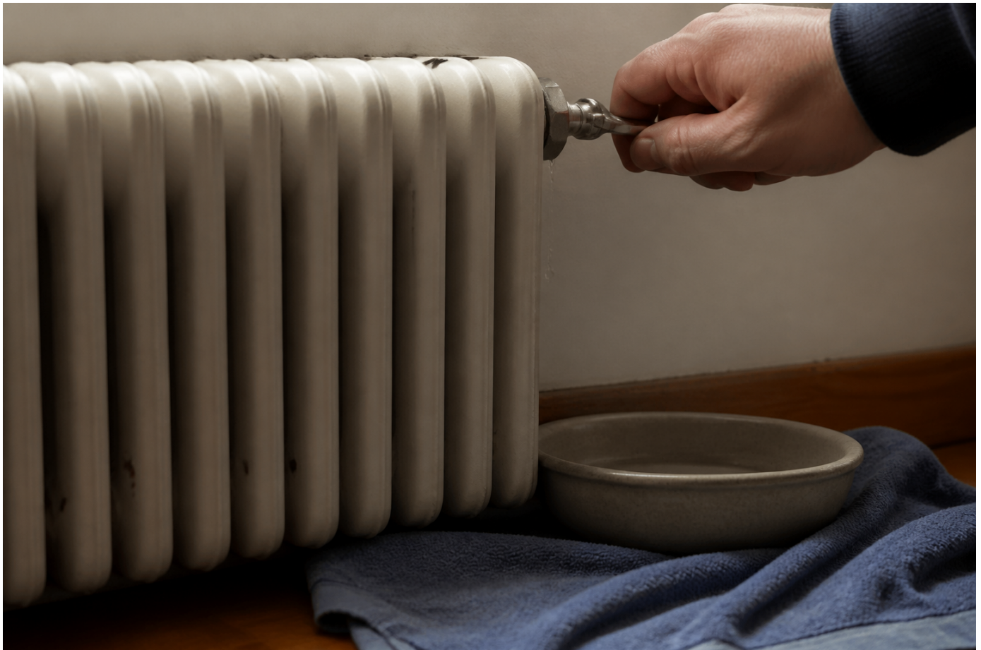
ILLUSTRATION Purge prudente d'un radiateur à eau avec une clé, un récipient et un chiffon.
